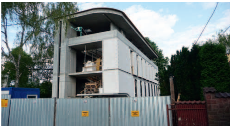
Ul. Jesionowa 3. „Rozbudowa wraz z przebudową budynku mieszkalnego jednorodzinnego”
