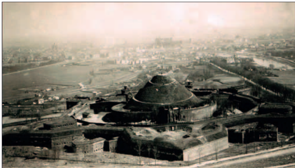
Widok fortów wokół Kopca Kościuszki na lotniczej fotografii z lat 20. ub. wieku. Po prawej nieistniejący, rozebrany bezmyślnie po ostatniej wojnie fragment fortyfikacji od strony południowo-zachodniej.
