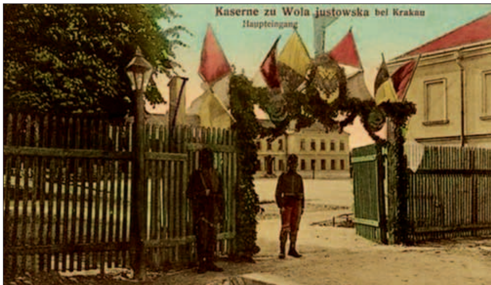
Wejście do koszar piechoty przy dzisiejszej ul. Modrzewiowej. Od 1991 roku działa tam Krakowskie Centrum Rehabilitacji.
