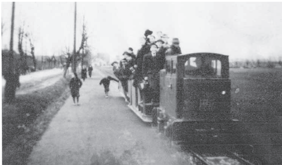
Kolejka łącząca siedzibę wodociągów na Bielaniach z wodociągiem rezerwowym na Zwierzynicy kursowała do ok. 1955 roku, a więc mniej więcej 40 lat. Po lewej ul. Księcia Józefa, jeszcze bez asfaltu... (fot. pierwsza poł. lat 50.).
