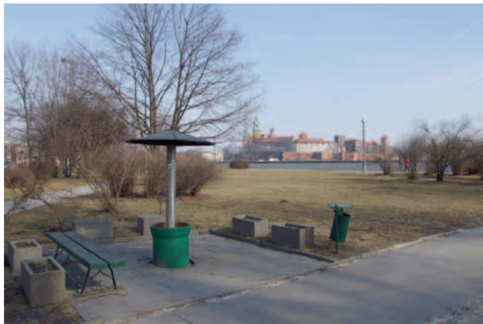
Skwer przed rozpoczęciem robót remontowych. /fot. P. Kajfasz
