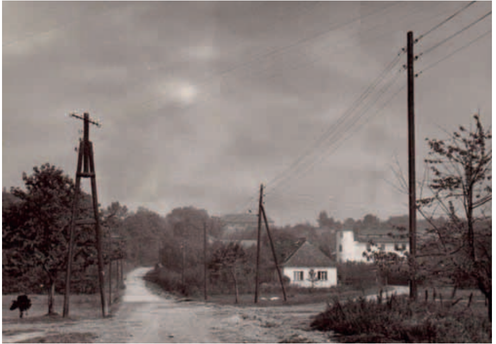
Fot. z pierwszej połowy lat 50. przedstawia fragment Przegorzał w ujęciu ze skrzyżowania dzisiejszych ulic Przegorzalskiej i Jodłowej. Jasny budynek z basztą to dawny dwór, adaptowany później na potrzeby Uniwersytetu Rolniczego. W głębi, na wyniesieniu przełęczony przegorzalskiej majaczy okazały budynek Domu Wezasów Dziecięcych PKP, dziś własność prywatna/Fot Ludwik Spiss junior
