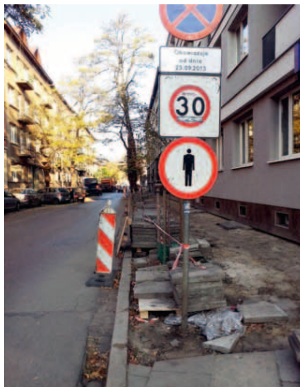
Chodnik podczas remontu
