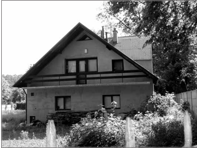
Jeden z przeznaczonych do wyburzenia domów jednorodzinnych obok Parku Decjusza
