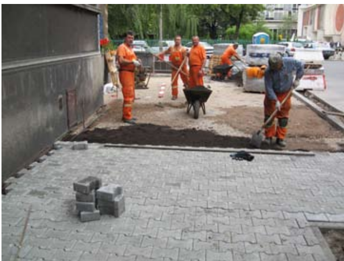
Ten sam chodnik w końcowej fazie remontu.
